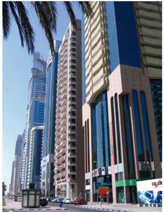
■ In anderen Teilen von Dubai City, wie etwa an der nach Scheich Zayed benannten Prachtstraße, entstehenden währenddessen jeden Tag neue luxuriöse Wolkenkratzer. Auch das derzeit höchste Gebäude der Welt wird derzeit hier gebaut. Bild: www.pixelio.de
