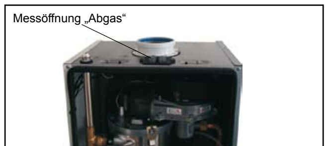
Bild: Abgasmessung bei geöffnetem Gerät
