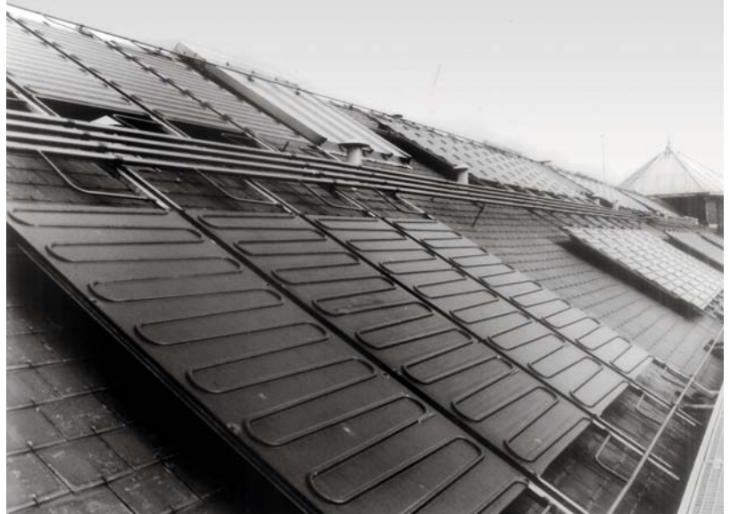
Abb. A.4.6–1 Wärmequelle unverglaste Absorber
