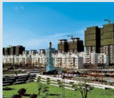
Wohnanlage „Zi Wei Garden“ Xi'an, China
