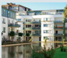
Mehrfamilienhaus „Wohnoase“ Regensburg, Deutschland
