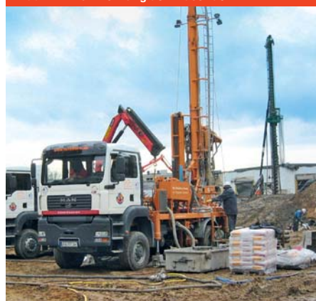
Abb. A.4.1–6 Bohrung der Erdsonde
