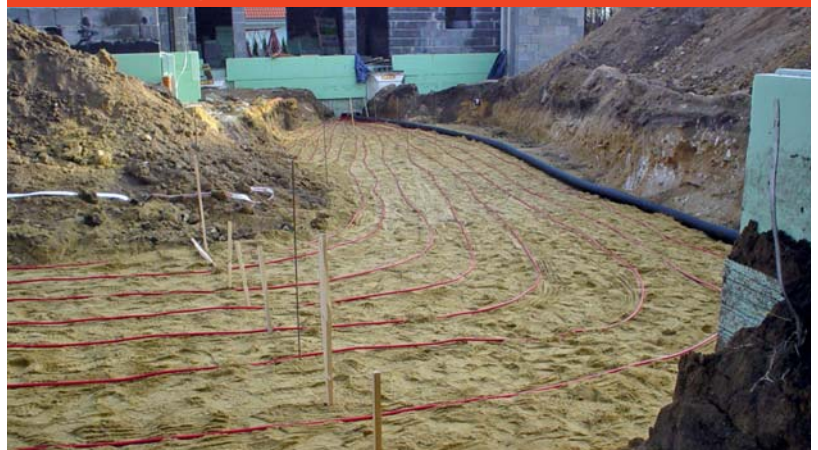
Abb. A.4.1–2 Wärmequelle Erdkollektor
